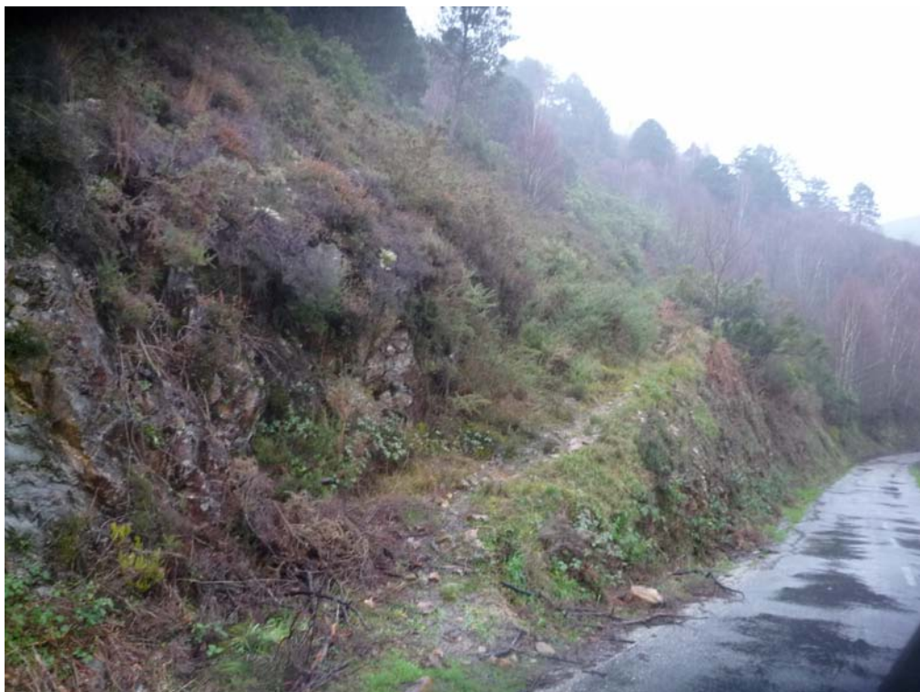
Fotografía n°8: inicio del tramo de ensanche de pista en su entronque con la carretera que une Castaosa y Sena.
